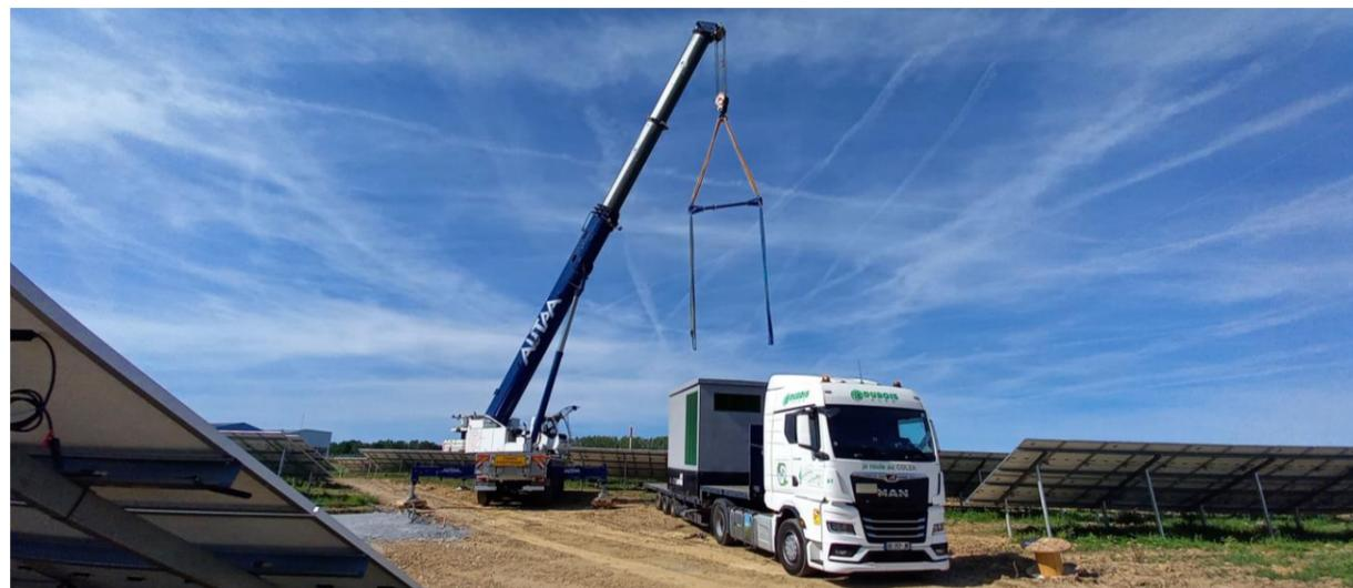
Figure 20 : Installation d'un local technique
