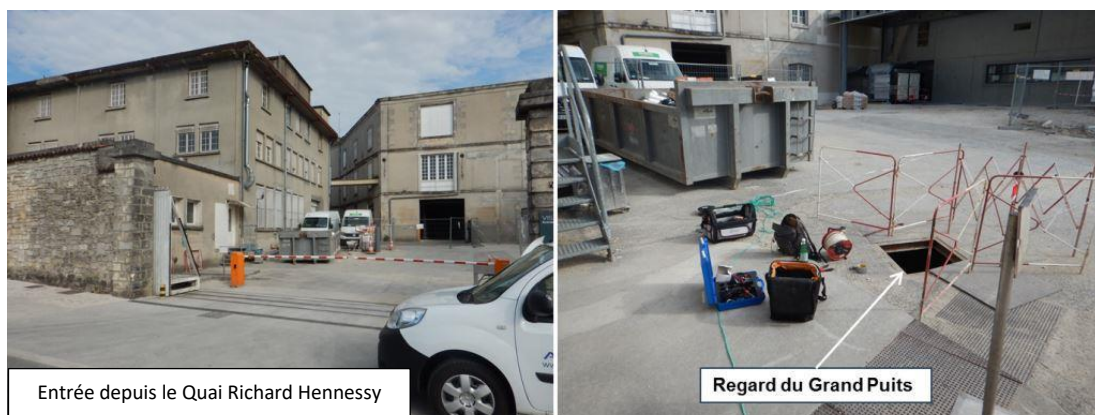
Figure 9 : Photo de l'environnement autour du puits et de son regard
