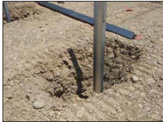
Figure 7 : Types de fondation - pieux battus (Source : Guide MEDDTL 2011 – NCA, 2015)
