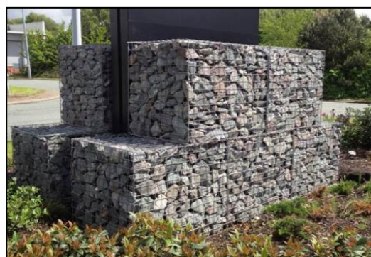
Figure 9 : Fixation par des gabions (Source : TCS Geotechnics)
