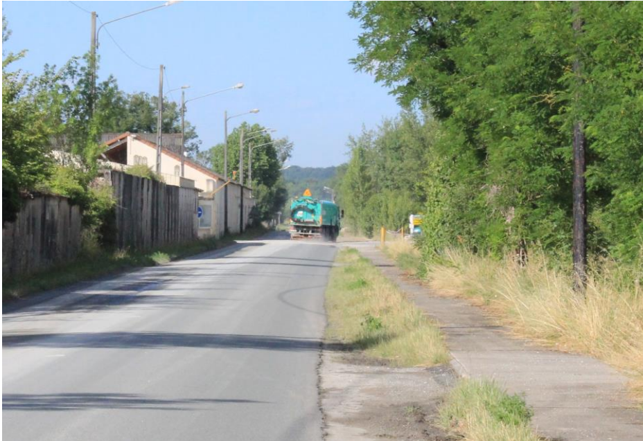
Figure 11. Photographie de l'arroseuse sur la RD 48
