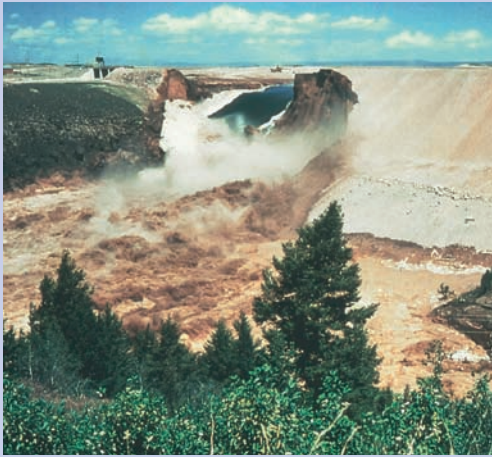
Rupture de barrage en terre. Le barrage de Teton (Idaho, États-Unis, 1976).
