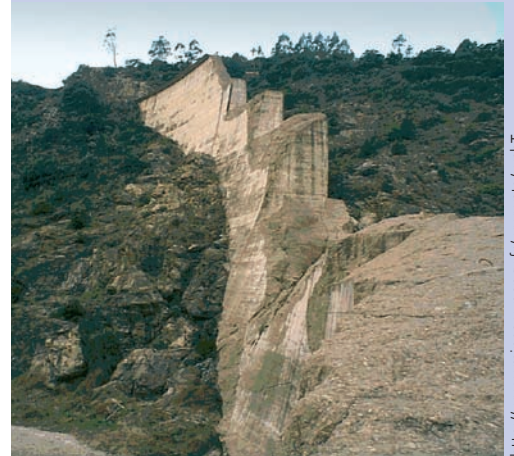
Rupture de barrage en béton. Le barrage de Malpasset (Var, France, 1959).
