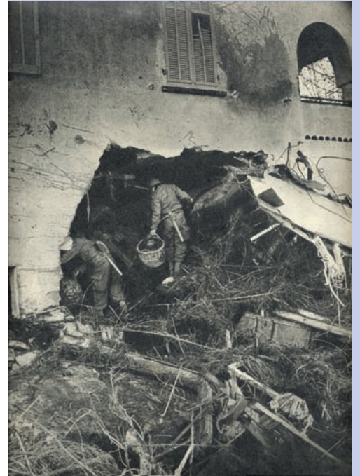
Dégâts de la catastrophe de Malpasset
