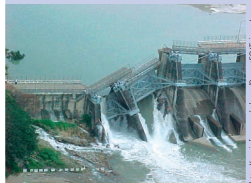
Rupture de barrage en béton. Le barrage de Shih-Kang (Taiwan, 1999).
