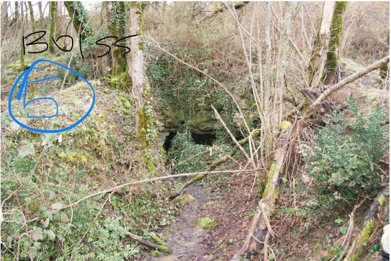
Documents 3, 4 et 5 : entrées des galeries de la mine de la Boissière
