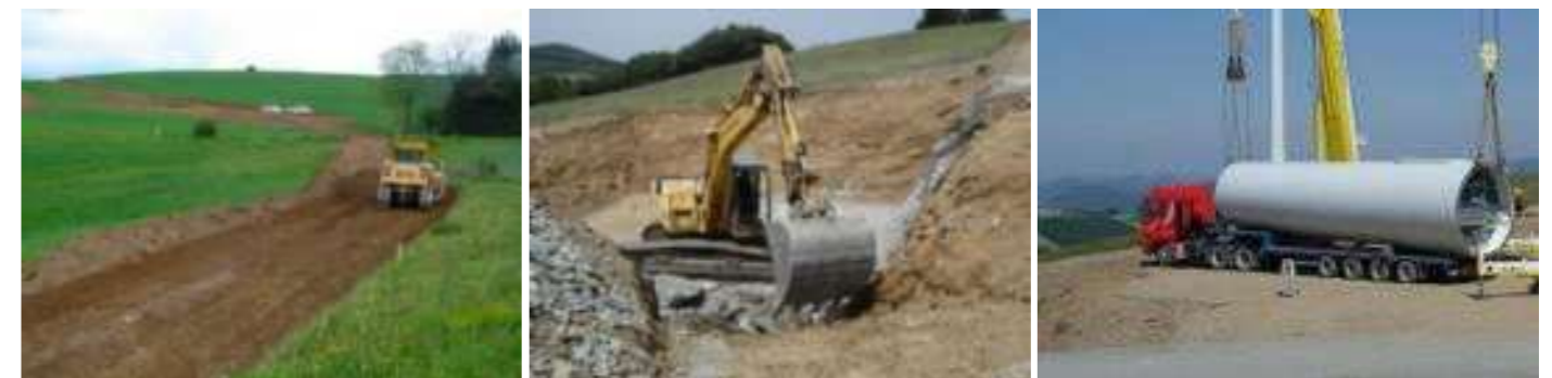
Photographie 133 : Illustration d'un chantier éolien
