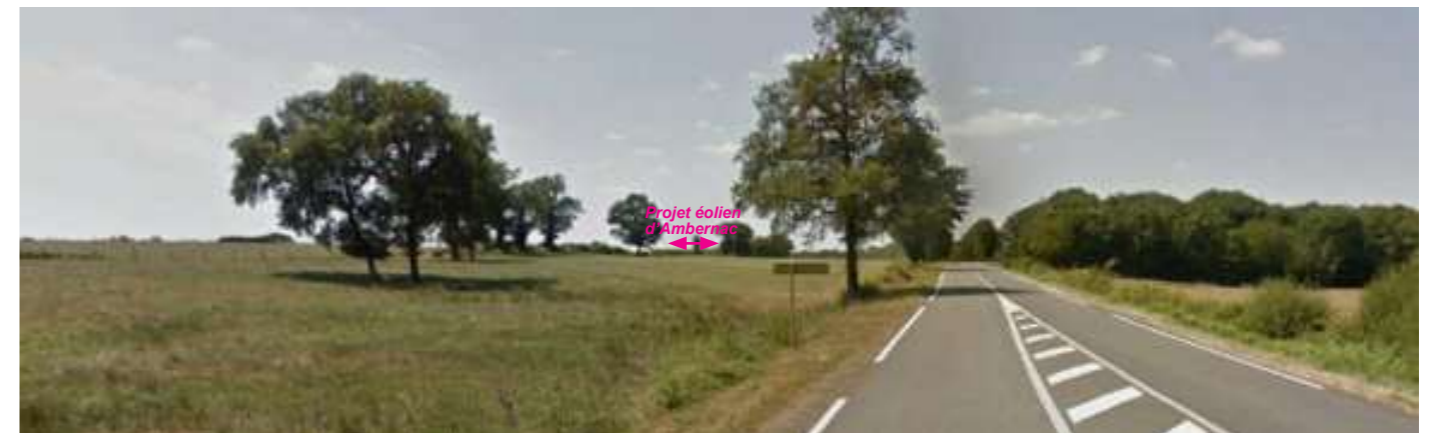
Photographie 136 : Vue en direction du projet éolien depuis la D951, depuis le plateau bocager délimité par la Vienne et l'Issoire au nord-est de l'AEE (source : Google Street view).
