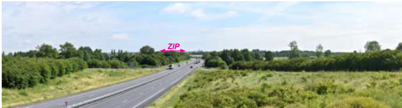
Photographie 18 : Perception très partielle de la ZIP depuis le pont de la D62 qui surplombe la N141 au sud de Chasseneuil-sur-Bonnieure.
