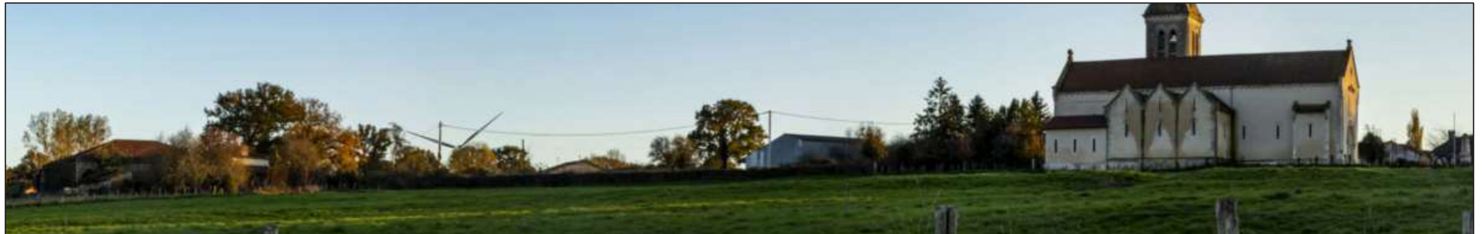
Photographie 156 : Photomontage illustrant la covisibilité entre le projet éolien et l'église d'Ambernac depuis la route de Puynode Bas (photomontage n°40 du carnet de photomontages).
