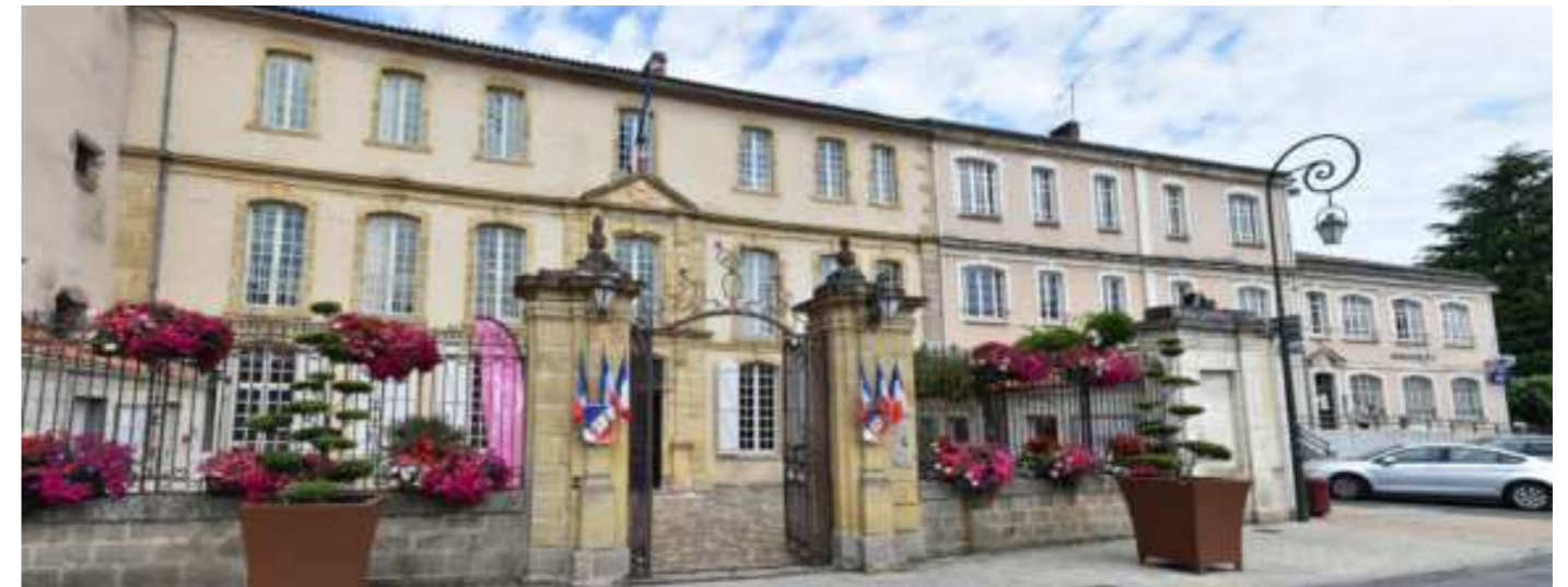
Photographie 57 : L'hôtel Dassier des Brosses abritant aujourd'hui la mairie.
