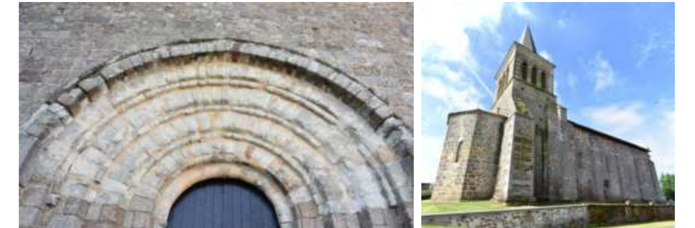
Photographie 28 : L'église Saint-Pierre de la Péruse (MH n°42).
