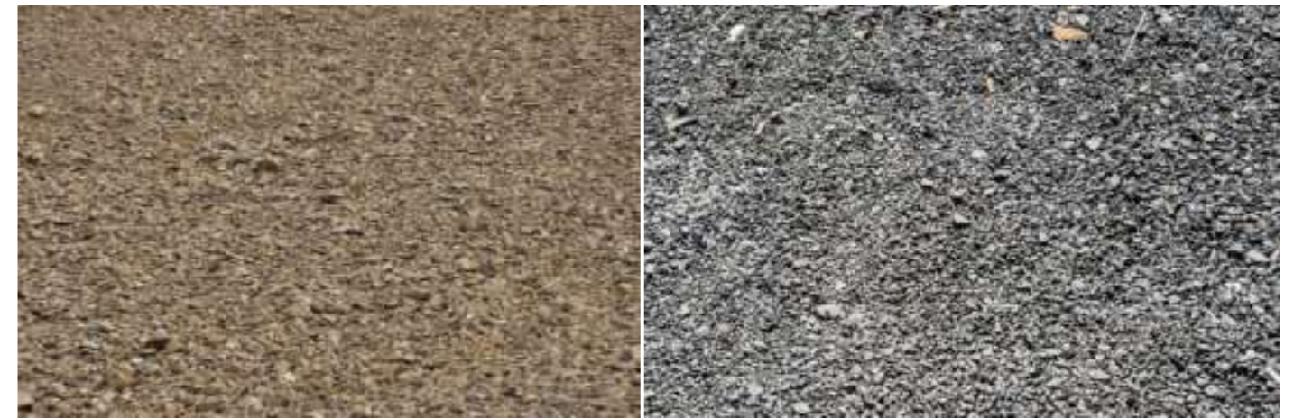
Photographie 130 : Texture des pistes en concassé calcaire / granit.
