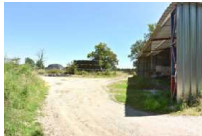
Espace de stockage et hangar agricole
