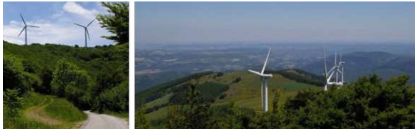
Photographie 131 : Vue en contre-plongée et vue en plongée du parc éolien de Merdélou (photo : F. Bonnenfant).
