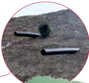
Exemple de système de drainage
