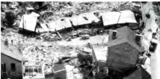
Le 1<sup>er</sup> juin 1961, un énorme grondement souterrain se fait entendre et, quelques instants plus tard, six hectares de carrière de craie s'effondrent sur une hauteur de deux à quatre mètres à la limite des
