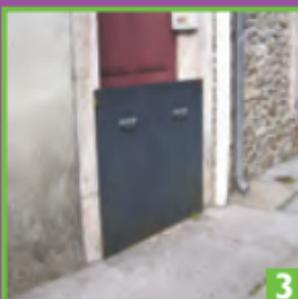
Des dispositifs permettent de diminuer la vulnérabilité des bâtiments tels que les batardeaux.
