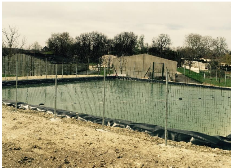
Figure 13 Bassin de réserve d'eau incendie de 750 m 3
