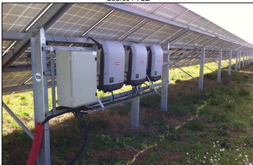
Illustration 16 : Exemple d'onduleurs strings fixés à l'arrière des tables de modules
