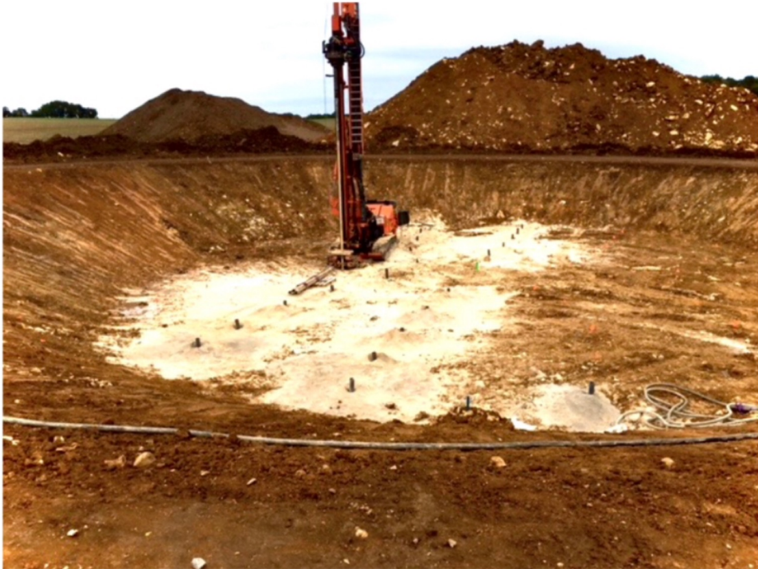
© apache chassiecq - Une des excavations à Turgon: le socle karstique est atteint
