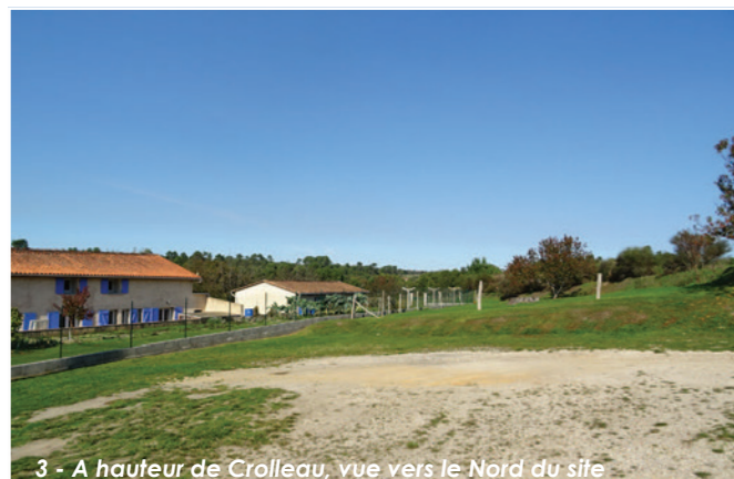
3 - A hauteur de Crolleau, vue vers le Nord du site
