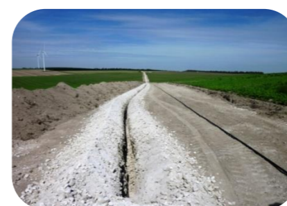
Réalisation des pistes et du câblage
