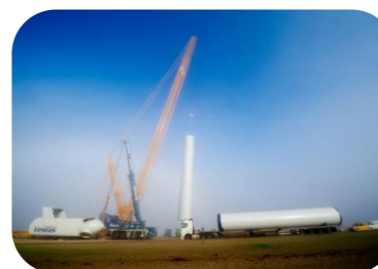
Livraison et Montage des tronçons de mâts
