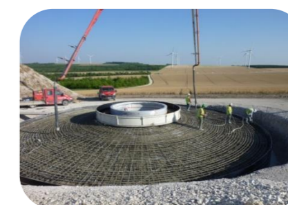
Coulage de la fondation
