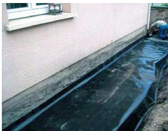
Figure 22 Géomembrane en cours de pose (Source Socabat)
