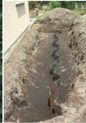
Figure 27 Écran métallique (Source Socabat)
