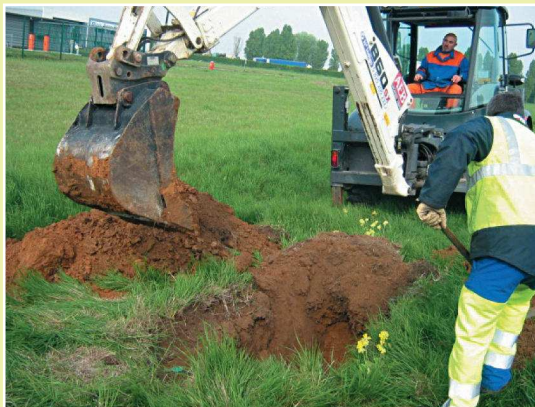
Sondages à la pelle mécanique dans des matériaux limoneux (Source Cerema)
