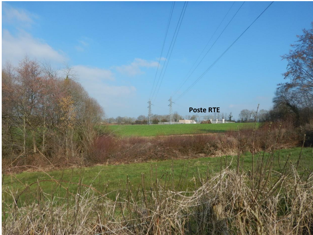
Vue I : Vue depuis la limite de propriété actuelle de la parcelle (clôture) vers le poste électrique RTE
