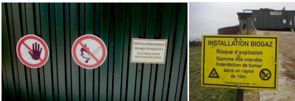
Figure 61 : Exemple de signalétique de zone ATEX sur le bardage d'un digesteur et à proximité des installations (Crédits photos : NCA, 2011 et 2012)
