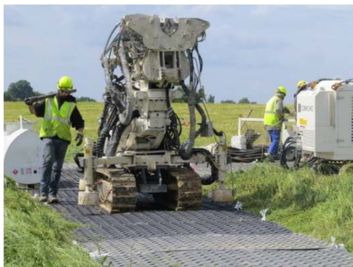
Engin à chenilles progressant sur plaques
