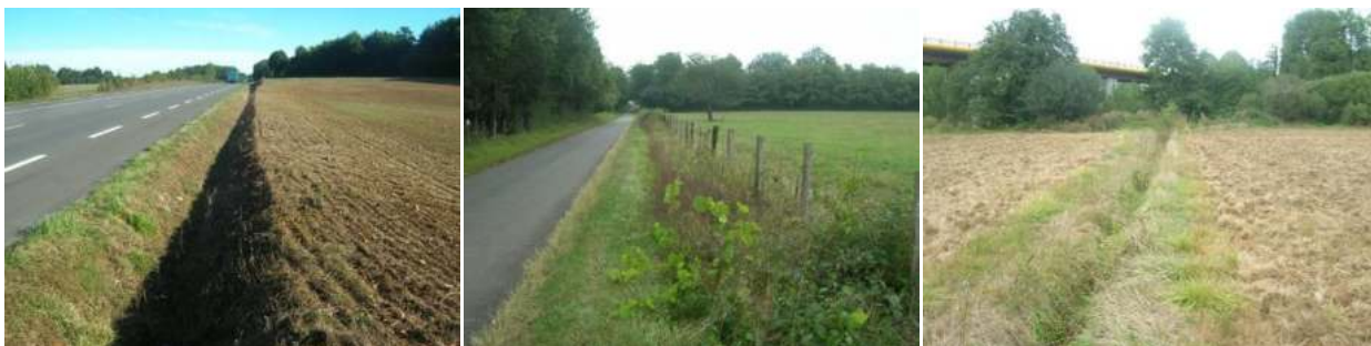
Photos 1 à 3. De gauche à droite : fossé dégagé en bordure de route, fossé encombré en bordure de route et fossé de drainage d'une prairie.
