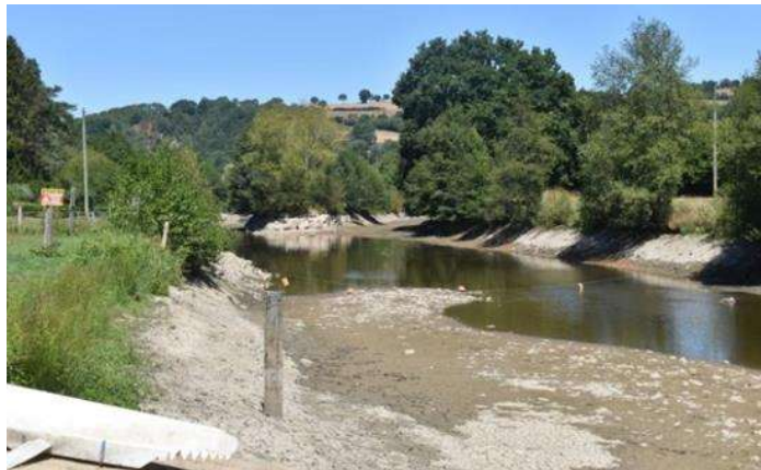
La Vire à quelques km près de Pont-Farcy après destruction d'une chaussée (on aperçoit l'ancien lit et le nouveau...)
