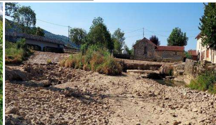
Aval de la chaussée : rivière à sec
