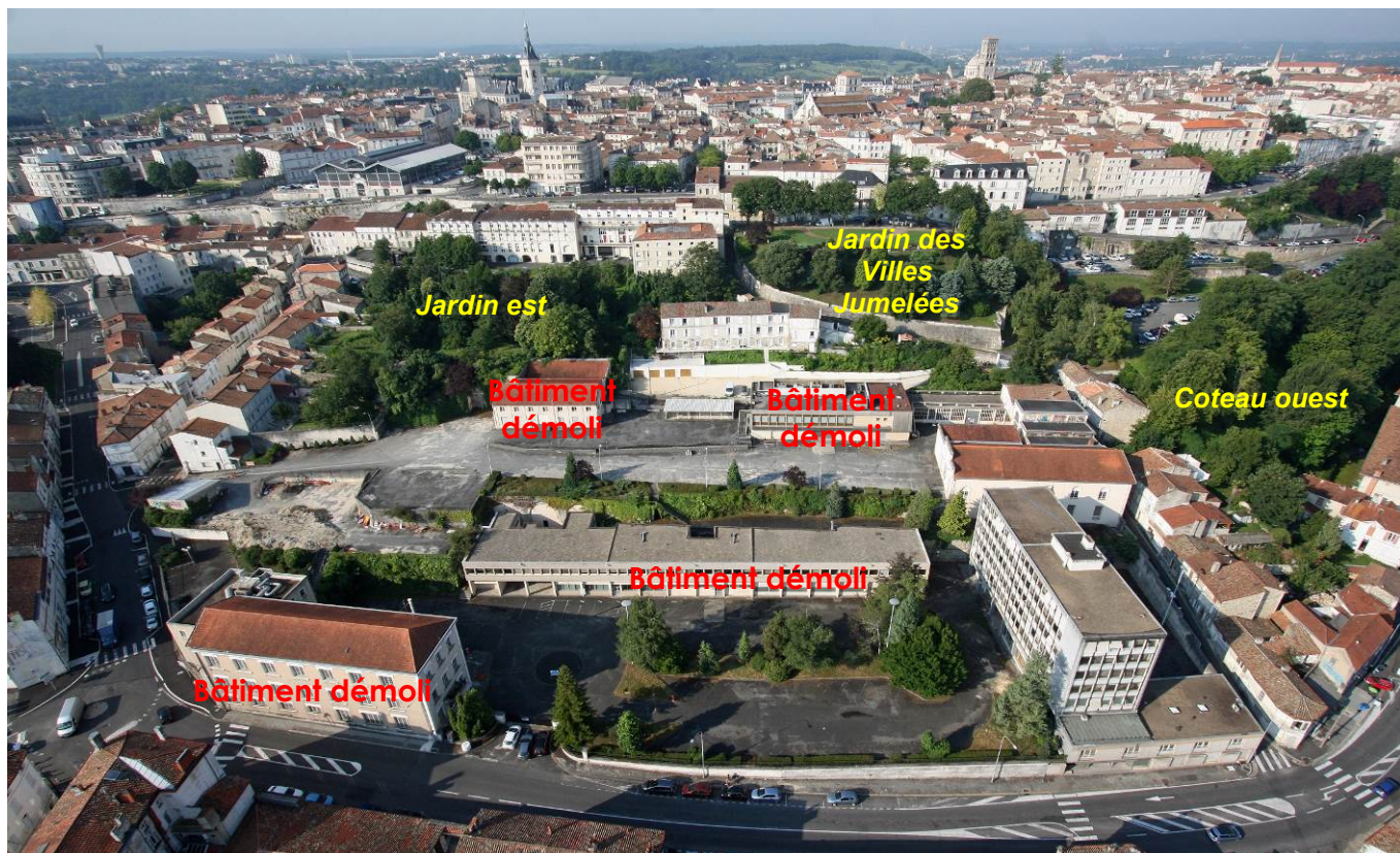
Vue aérienne prise du nord vers le sud (ville haute) mettant en évidence la continuité verte du coteau et l'échelonnement des bâtiments sur le coteau
