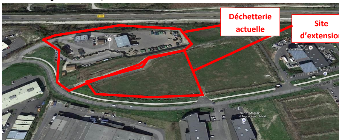
Figure 16 : Vue aérienne de l'occupation locale des sols
