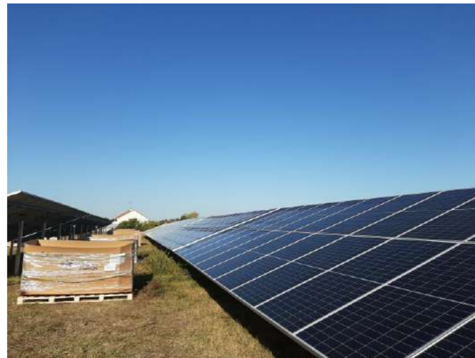
Figure 76 : Montage des modules
