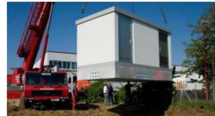
Figure 77 : Livraison d'un local technique
