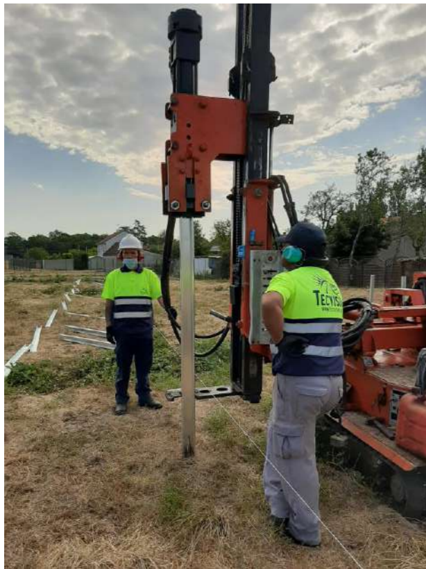
Figure 75 : Montage des structures porteuses
