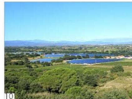
10 Intégration définie selon les trames viaires et naturelles (linéaire de boisement) existantes.
