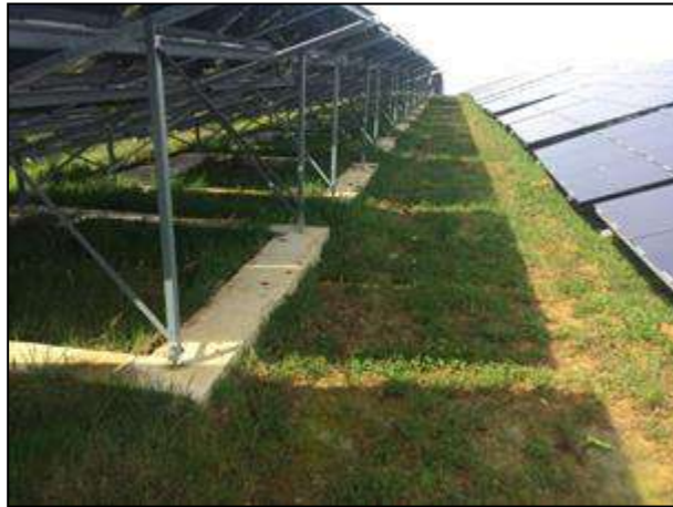
Reprise végétale sous les panneaux photovoltaïques
