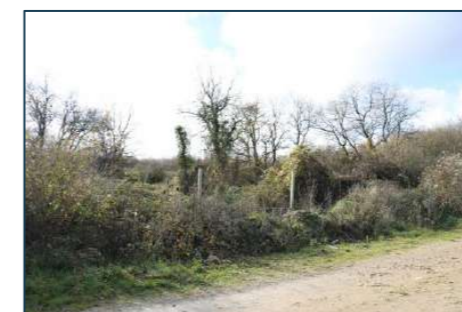
Accès au site (portail embroussaillé) Source : Artifex 2020
