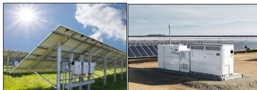
Figure 19 : Comparaison de différents onduleurs : strings ou centralisé
