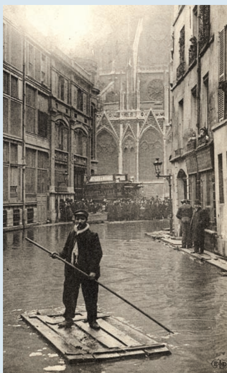
Inondation de Paris en 1910, rue Massillon
