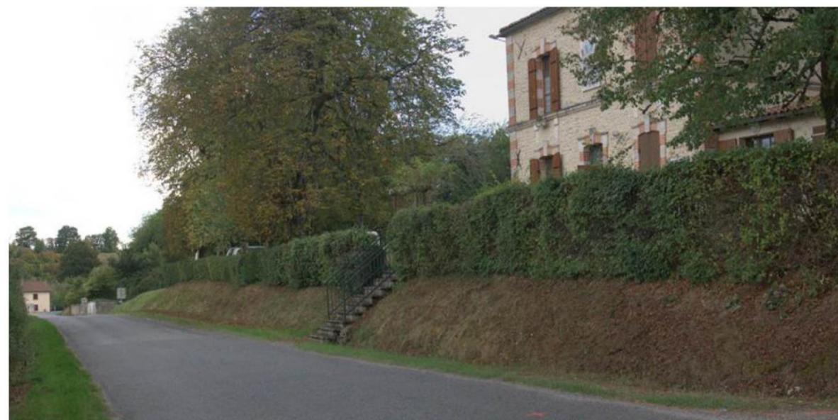
La mairie de Vieux-Ruffec et le talus à aménager : état actuel (source : WPD)
